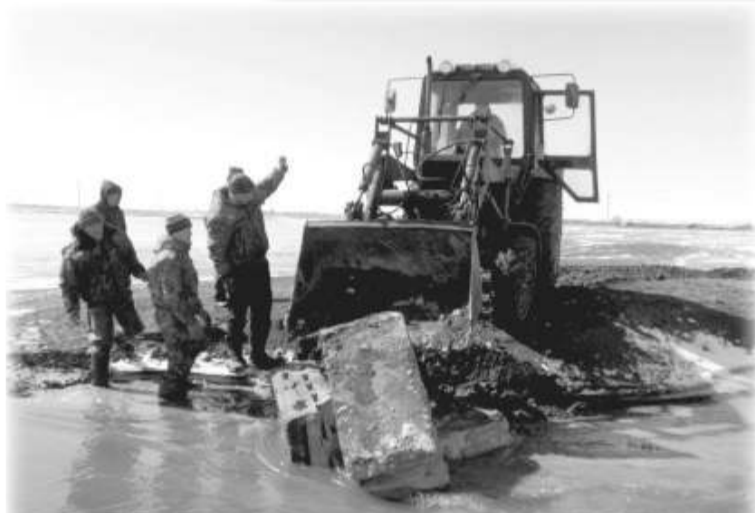
Луговопролейские фермеры сооружают новую дамбу.
